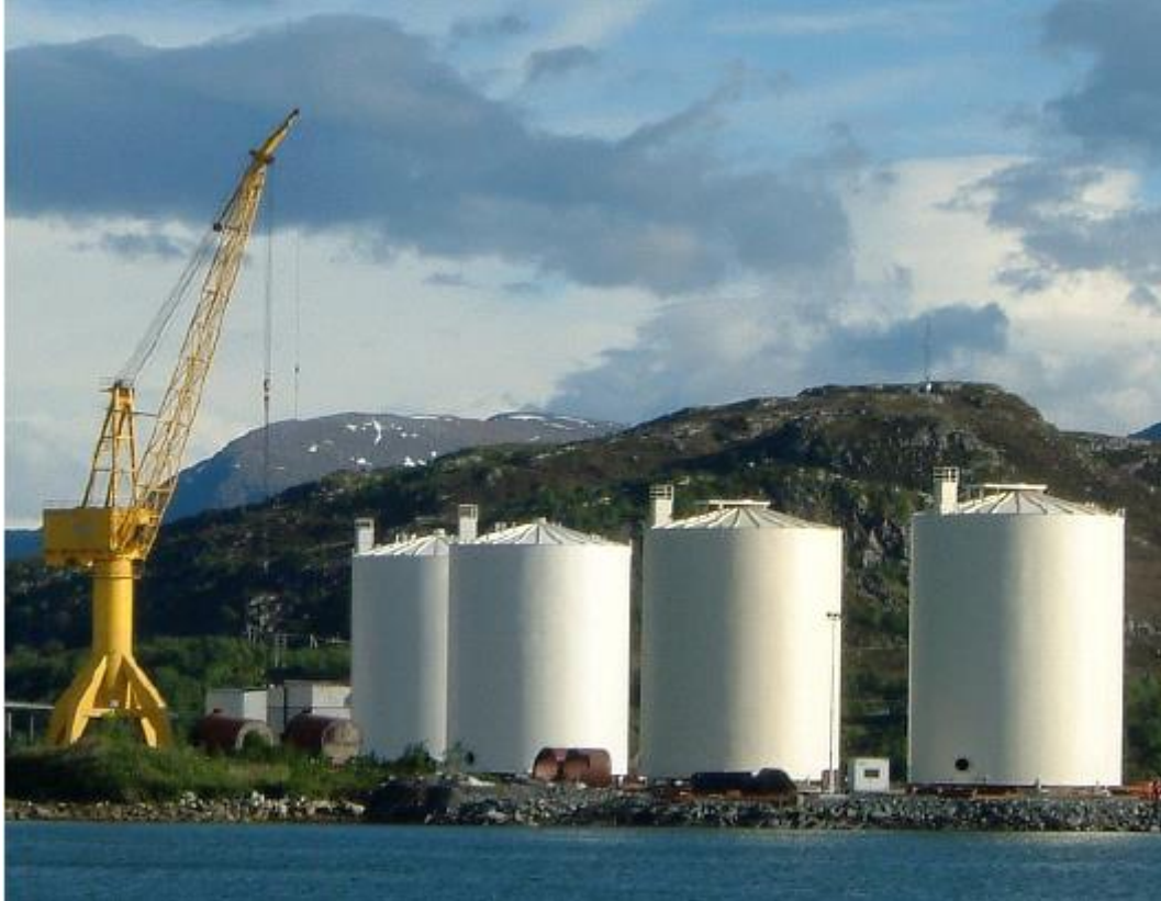
Slika 9. Spremnici za naftu izradeni od dupleks čelika LDX 2101 [16]
