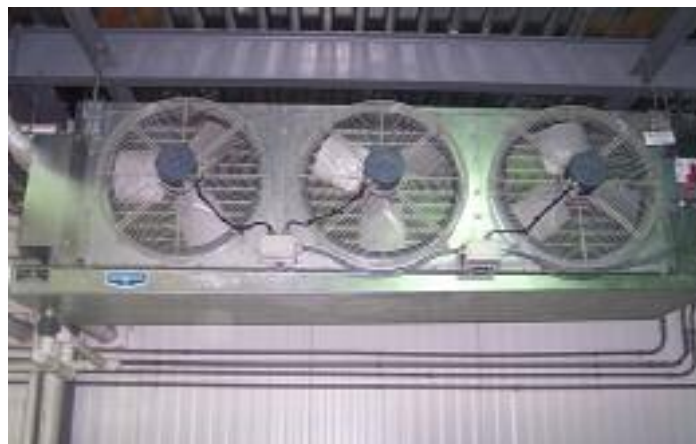
Slika 45: Prikaz montiranog isparivača u hladionici
