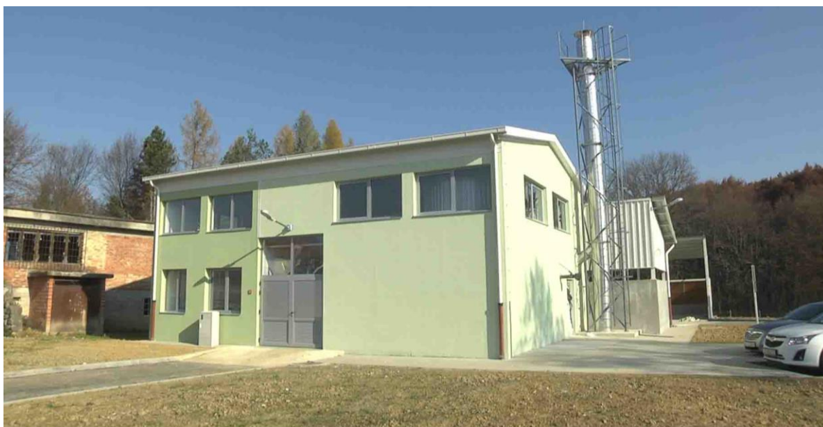
Slika 4 Toplana na biomasu u Pokupskom snage 1 MW [30]
