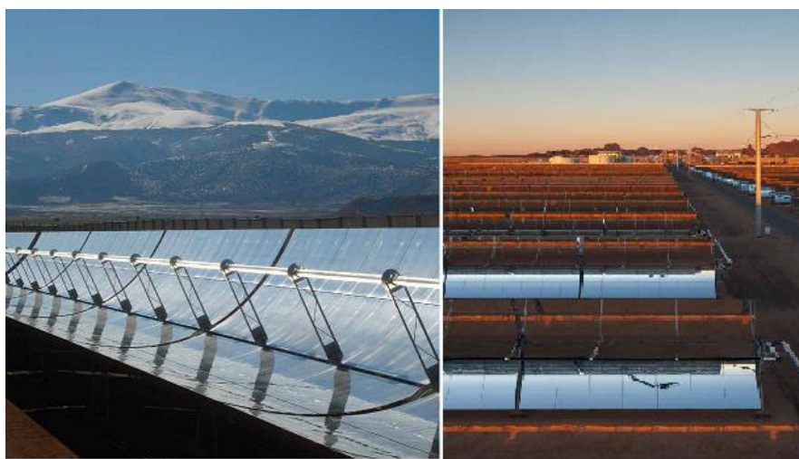
Slika 22. Parabolični žljebasti kolektori [9]
