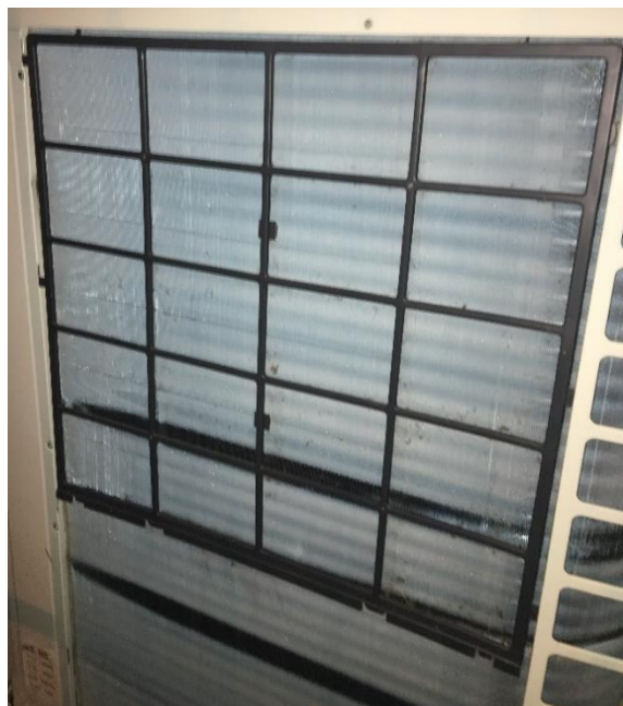
Slika 22. Led na isparivaču
