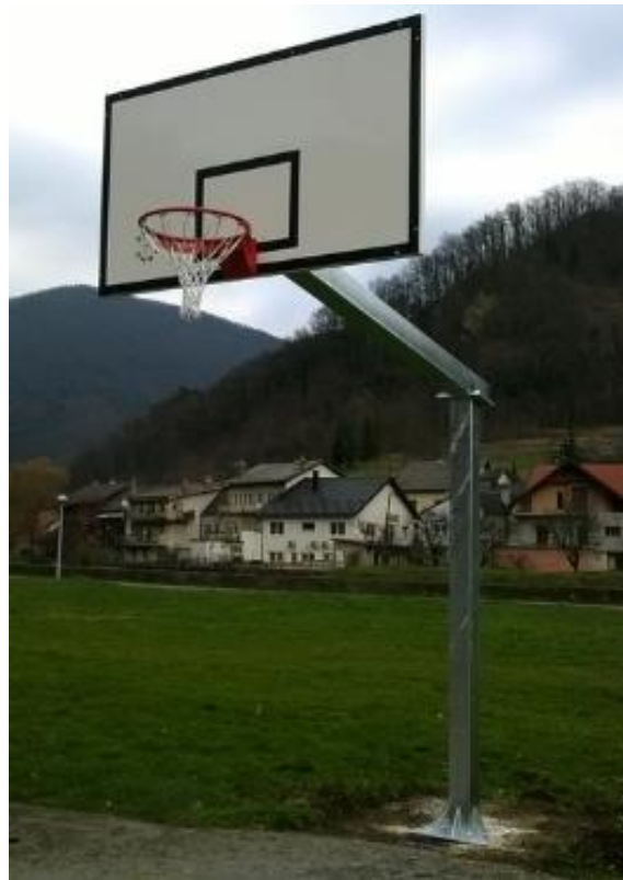
Slika 6. Fiksna konzolna konstrukcija [7]
