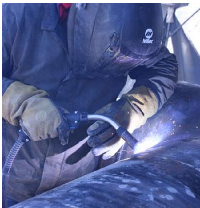
Slika 30. Ručno MAG zavarivanje čeličnih cijevi [8]
