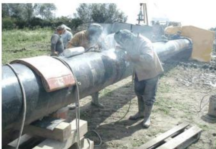
Slika 29. REL zavarivanje čeličnih cijevi celuloznom elektrodom [19]
