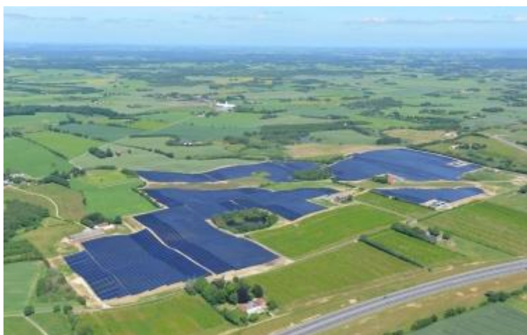
Slika 7. Solarni kolektori u Silkeborgu [9]
