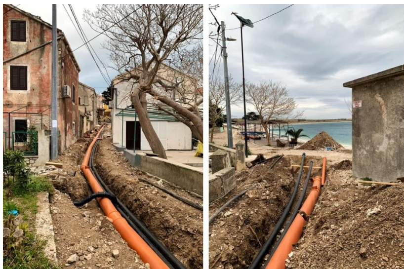
Slika 16. Proces izgradnje vodovodne i kanalizacijske mreže [44]
