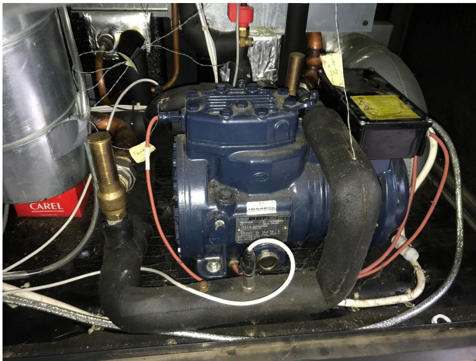
Slika 15. Kompresor Dorin ispitne dizalice topline
