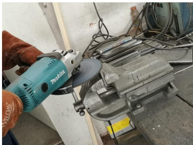
Slika 48. Priprema zida za zavarivanje
