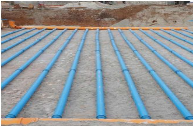
Slika 2. Primjer sustava s izmjenjivačem topline zemlja-zrak za školu u St Austellu, Ujedinjeno Kraljevstvo [3]
