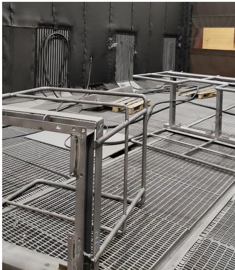
Slika 24. Pogon za sačmarenje u tvrtki Končar - Metalne konstrukcije
