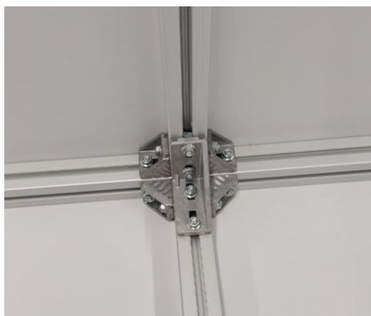
Slika 31. Spoj profila na testnom postavu
