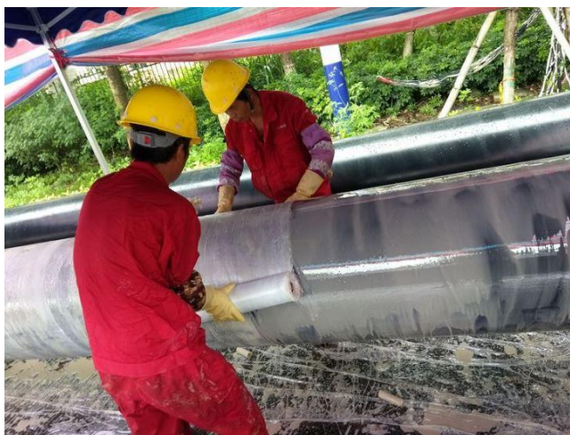
Slika 16. Oblaganje cijevi staklenim vlaknima [26]
