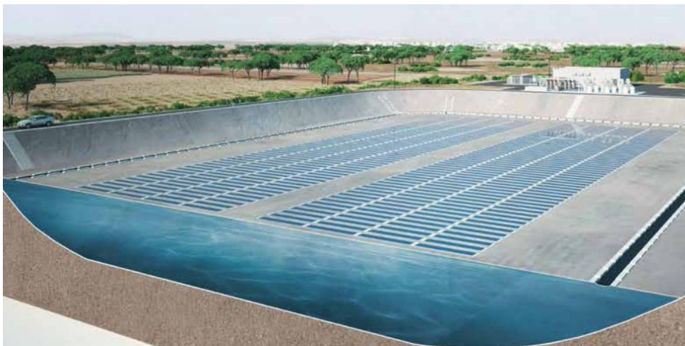
Slika 3.3 Primjer postavljenog FPV sustava na vodi [11]
