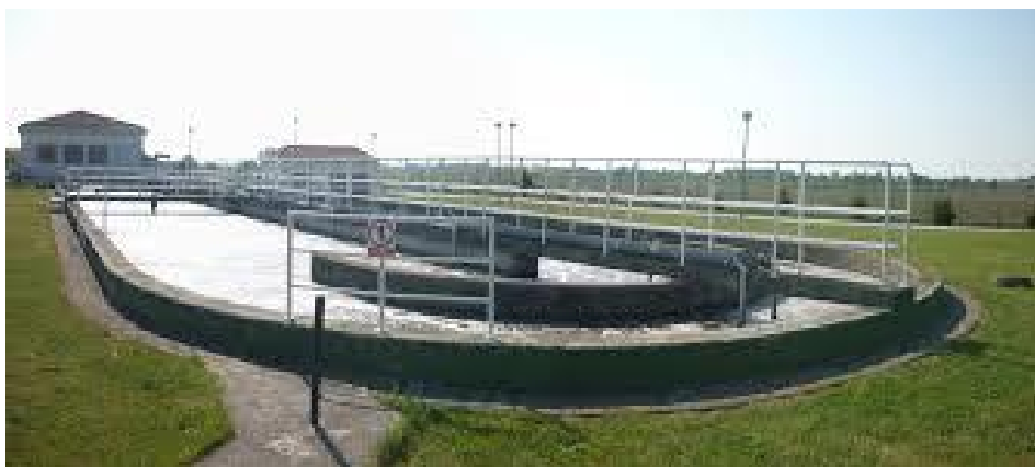
Slika 9. Bioaeracijski spremnici
