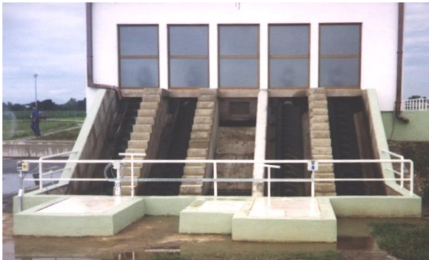
Slika 10. Crpilište biljnog mulja
