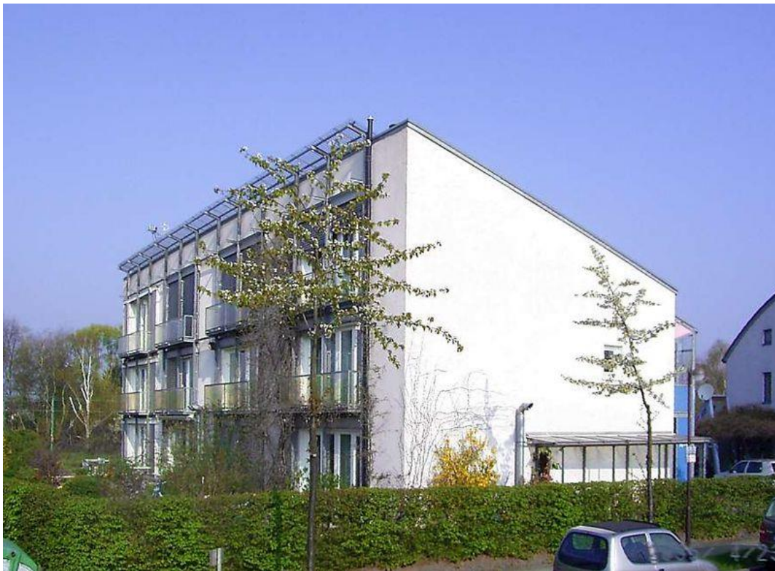
Slika 2. Pasivna kuća u Darmstadtu, Njemačka
