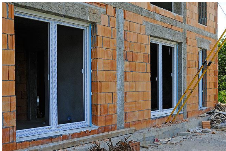
Slika 16. Izolacija propusnih mjesta na vanjskom plaštu kuće
