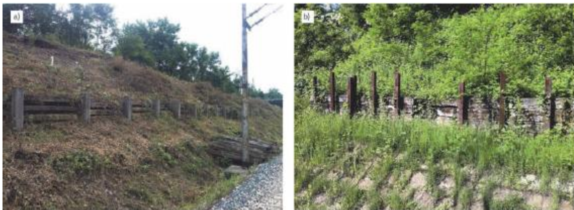
Slika 22. Sanacija klizanja tla: a) montažnim betonskim zidom; b) zidom od zabijenih tračnica i drvenih pragova (Udović i sur. 2014)
