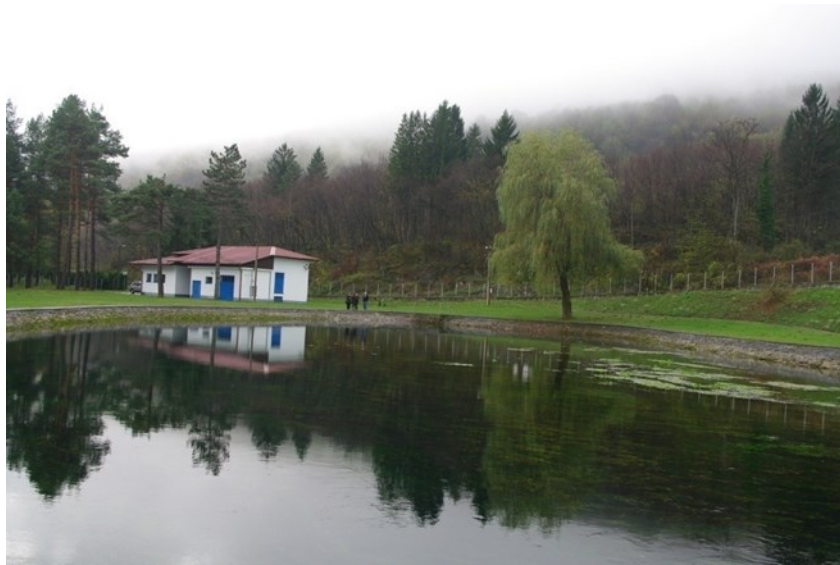
Slika 1. Crpna stanica i izvor Zagorske Mrežnice [1]
