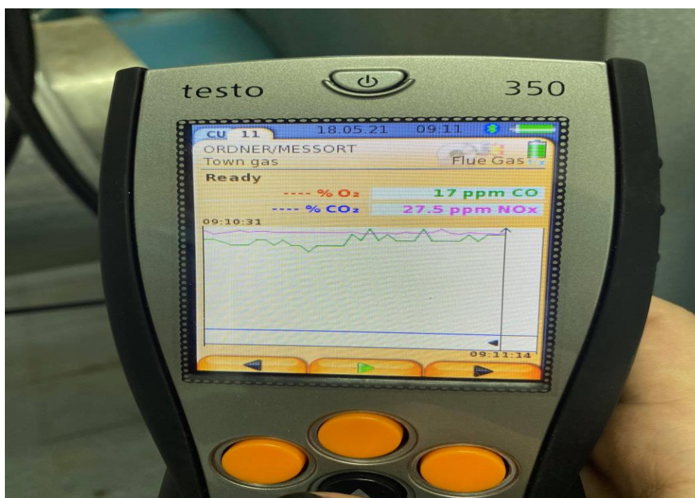
Slika 13. Krivulja emisije CO i NO x dobivena mjerenjem na prvom kotlu
