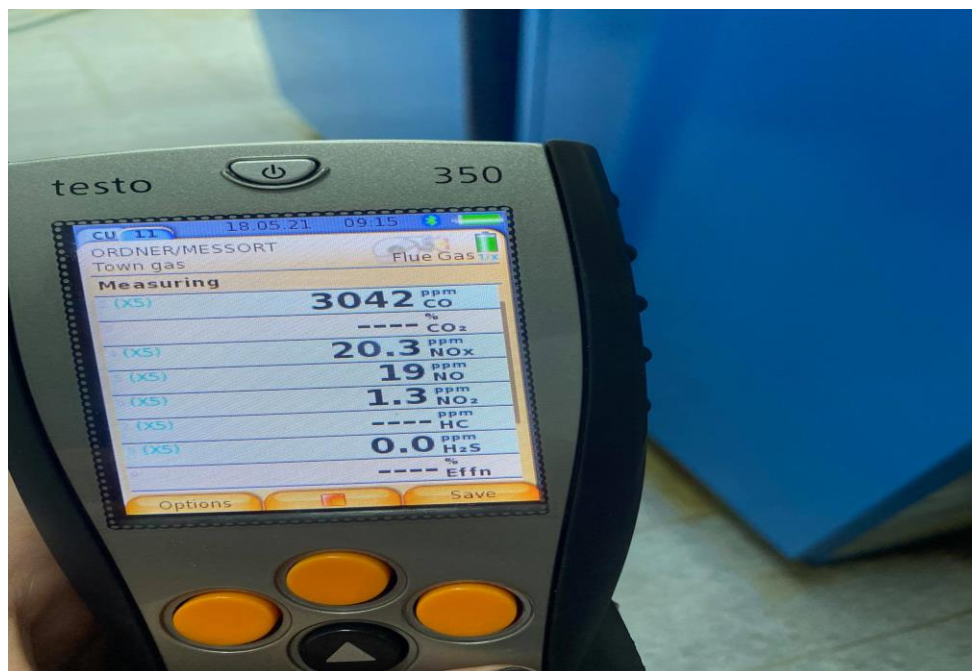
Slika 15. Očitanje dimnih plinova tijekom uključivanja drugog kotla
