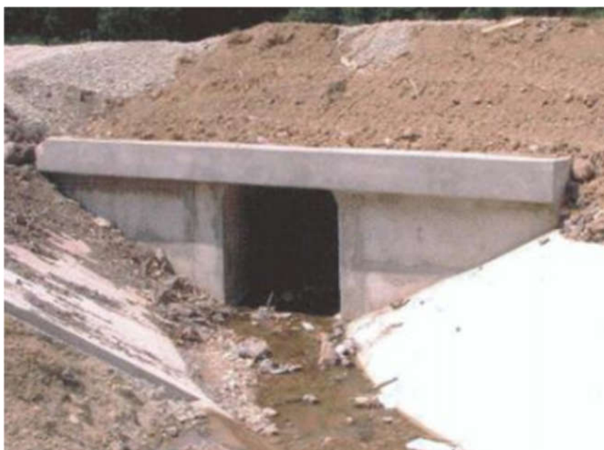
Slika 11. Pločasti betonski propust [3]
