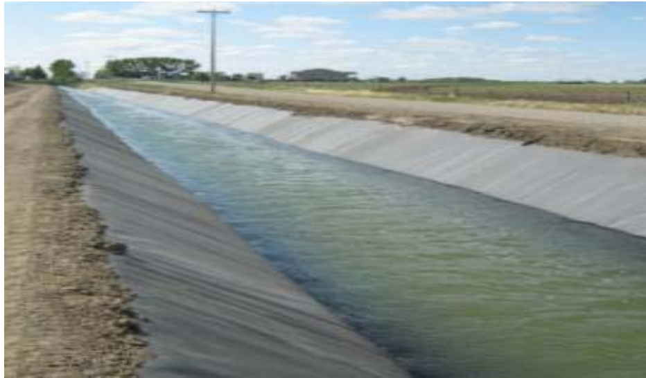
Slika 8. Obloga od plastičnih sintetičkih folija (geomembrana) [12]
