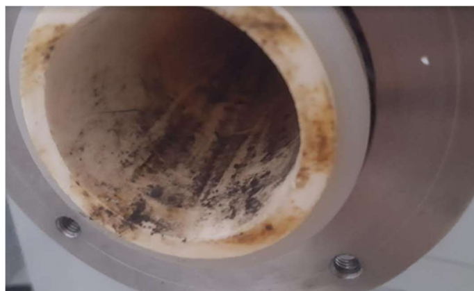
Slika 15: Vakuumska peć iznutra nakon eksplozije
