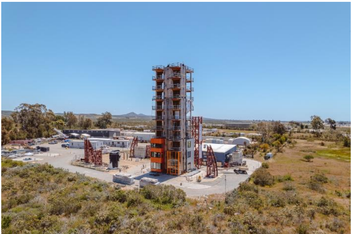
Slika 5 Potresno ispitivanje NHERI TallWood Project zgrade
