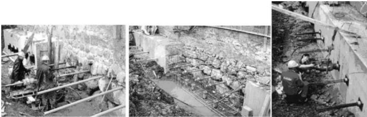
Slika 18 Detalji potpore pomoću pilota dvorca Malbork
