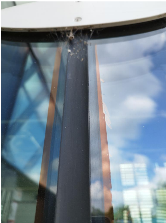
Slika 25 Primjer korodiranog low-E premaza
