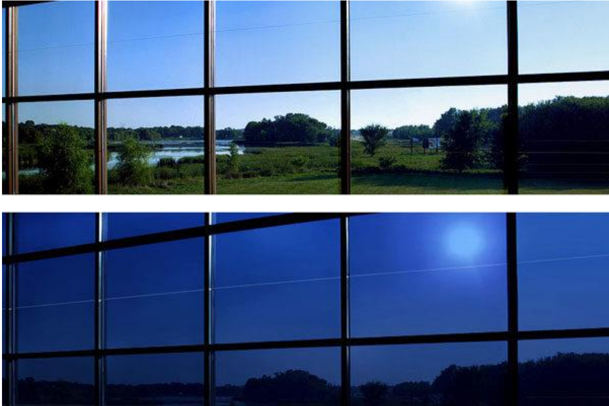
Slika 50 Prikaz SPD uključenog i isključenog stakla [57]
