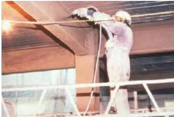
Slika 41 Ne reaktivni materijal za zaštitu – sprej ; a) nanošenje spreja b) požarna otpornost [5]
