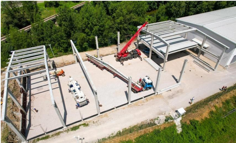
Slika 12. : Montaža uz pomoć autodizalice (Izvor [21])
