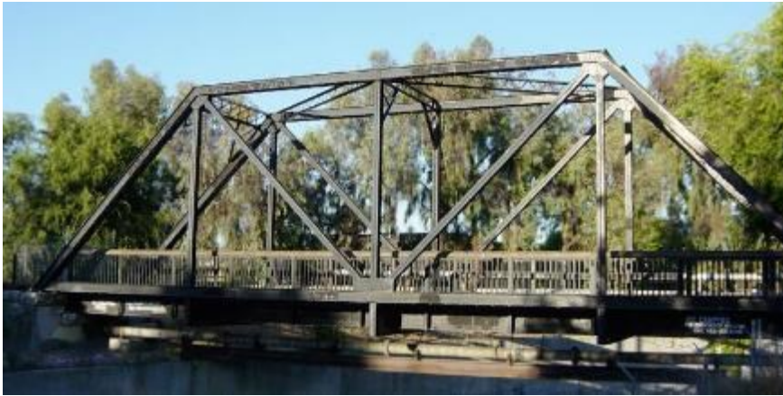
Slika 4. Rešetkasta konstrukcija u mostogradnji [8]
