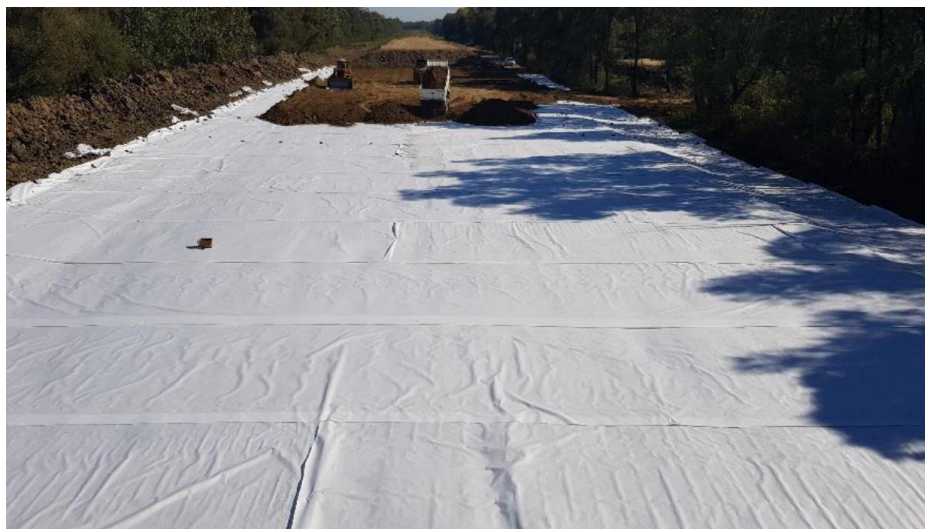
Slika 6 Ugradnja geosintetika u horizontalnim slojevima [5]
