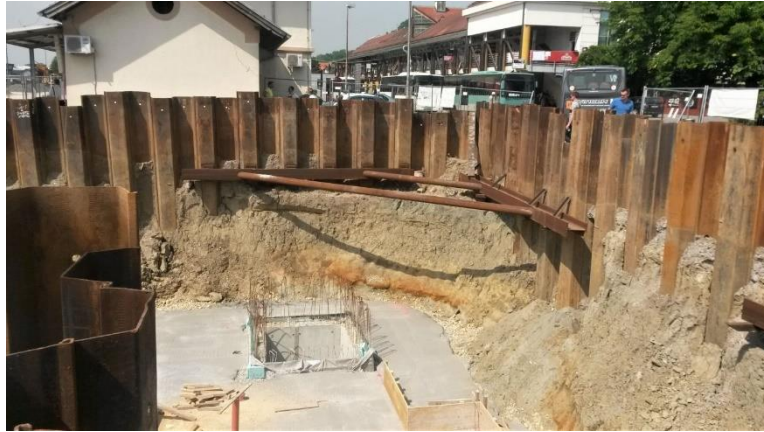
Slika 2. Zaštita građevne jame izvedbom talpi (izvor: Geotech, Rijeka)
