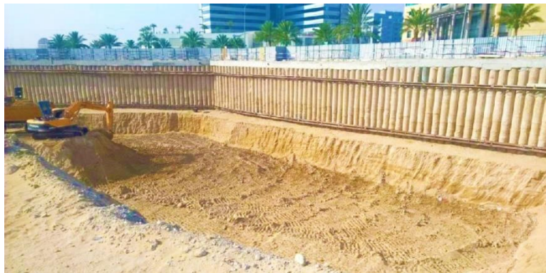
Slika 3. Zaštita građevne jame izvedbom pilotske stijene (izvor: Geotech, Rijeka)
