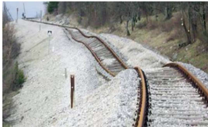
Slika 54: Posljedice deformirane posteljice na pruzi Lupoglav - Štalije (Izvor: [8])
