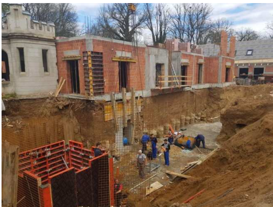
Slika 27.: Iskop do temelja [27]
