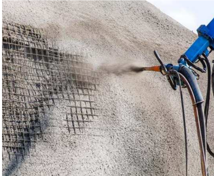
Slika 23.: Mlazni beton [23]
