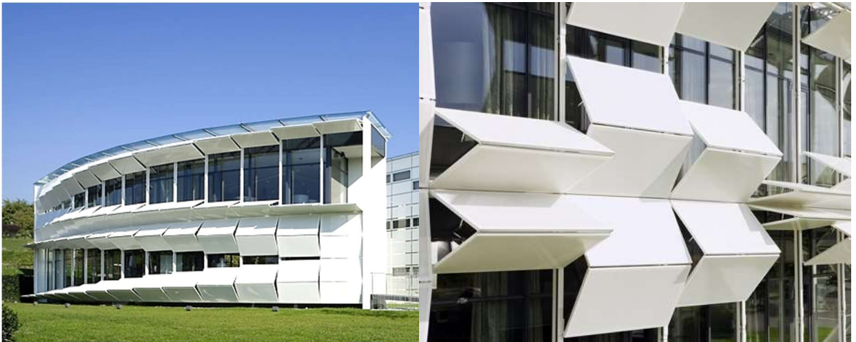
Slika 25. Sklopivi aluminijski elementi koji reguliraju prodor svjetlosti i topline Izvor: archdaily.com : Kiefer Technic Showroom / Ernst Giselbrecht + Partner | ArchDaily
