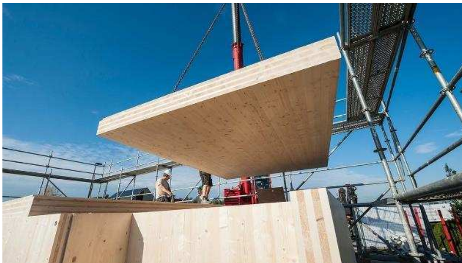
Slika 24: Montaža lameliranih ploča
