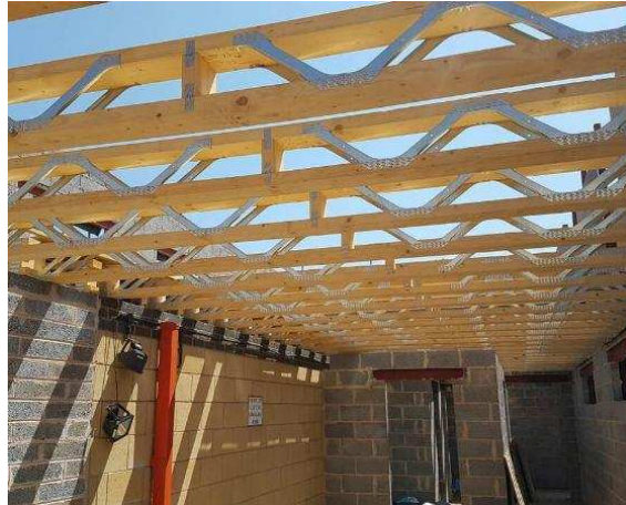
Slika 5: Rešetkasti nosači s čeličnom ispunom
