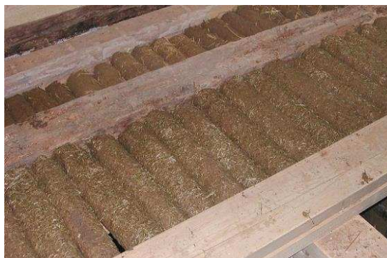
Slika 22: Ovojci ilovače složeni u drvenom gredniku
