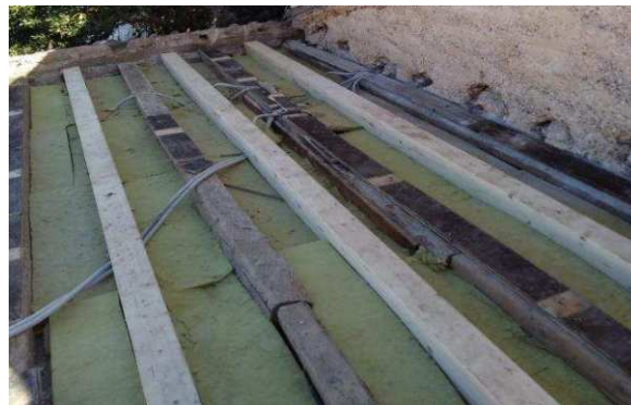
Slika 31: Drveni grednik s dodanim gredama i izolacijom
