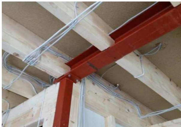
Slika 29: Drvene grede oslonjene na čelični nosač
