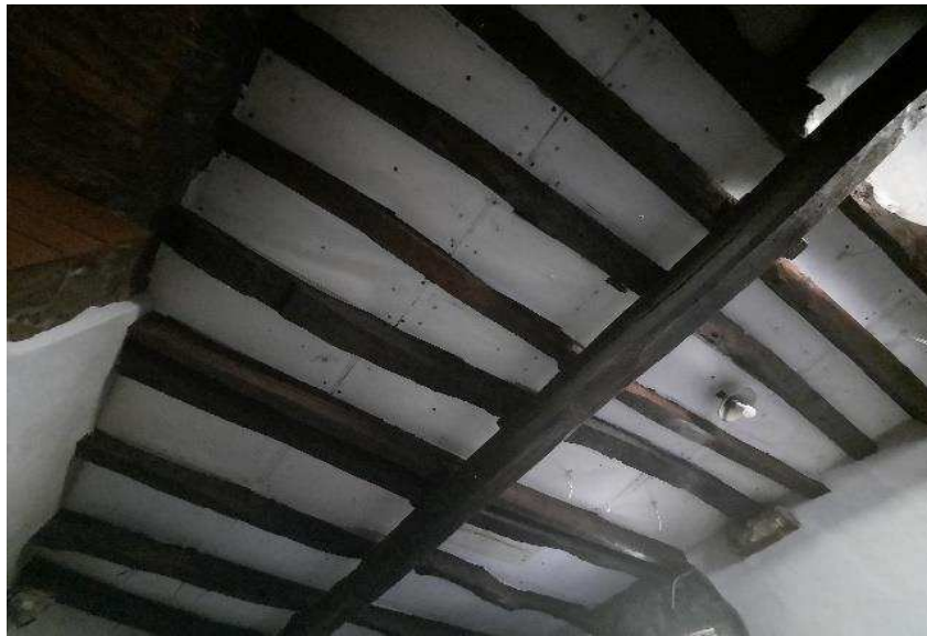
Slika 34: Drveni grednik s različitim međurazmacima greda
