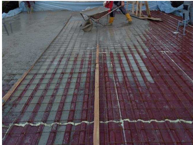
Slika 32: Betoniranje ploče na rebrastom limu
