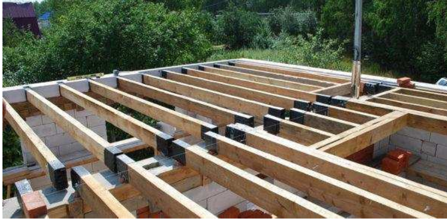
Slika 9: Drveni grednik s izoliranim glavama greda
