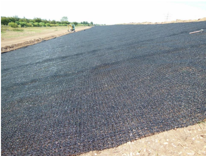
Slika 5 Postavljanje geosintetika na pokos nasipa [5]
