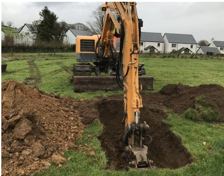
Slika 7 Iskop istražne jame [10]
