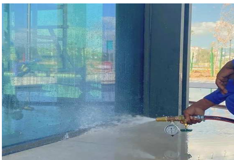
Slika 14.: Testiranje fasade vodom [14]
