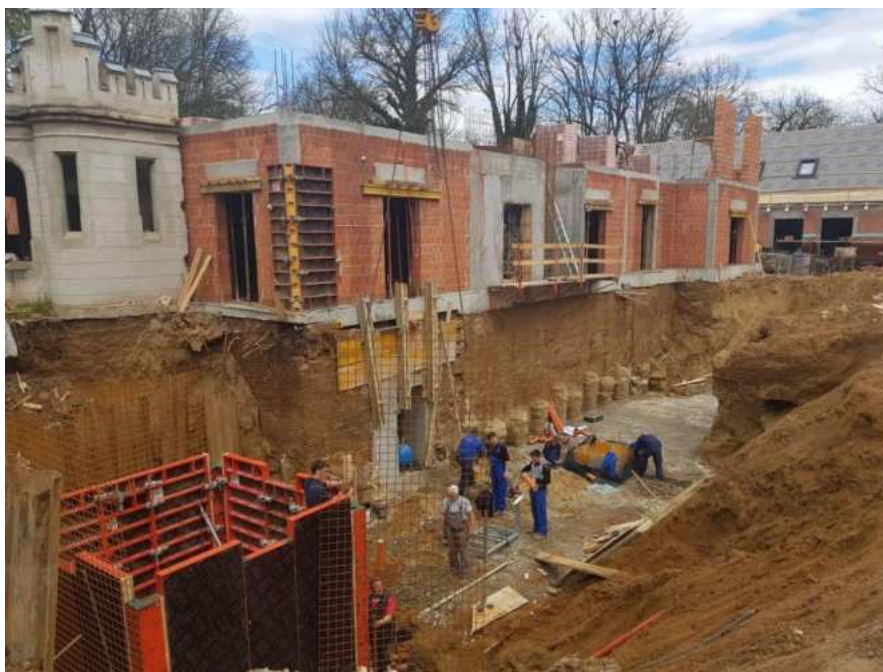
Slika 27.: Iskop do temelja [27]
