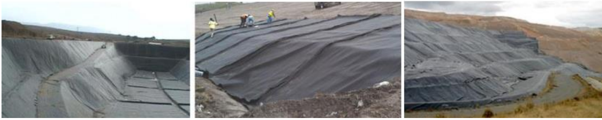
Slika 15.-:Postavljanje geomembrana (Izvor: [4])
