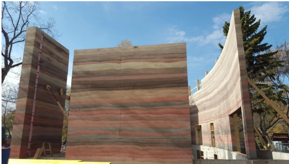
Slika 16: prikaz raznolikosti boja zida od nabijene zemlje [42]
