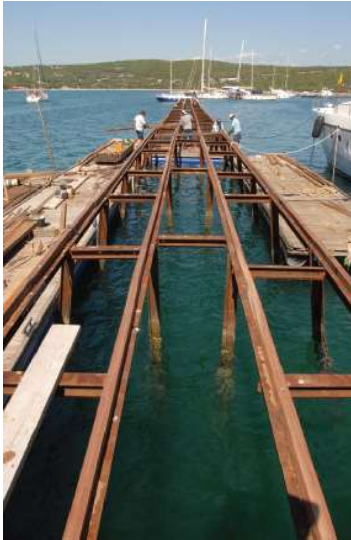
Slika 35: Konstrukcije gatova od tračnica 49 E 1 [2, 3]
