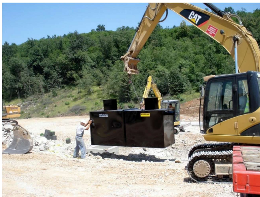
Slika 82: Prikazuje ugradnju separatora [20]
