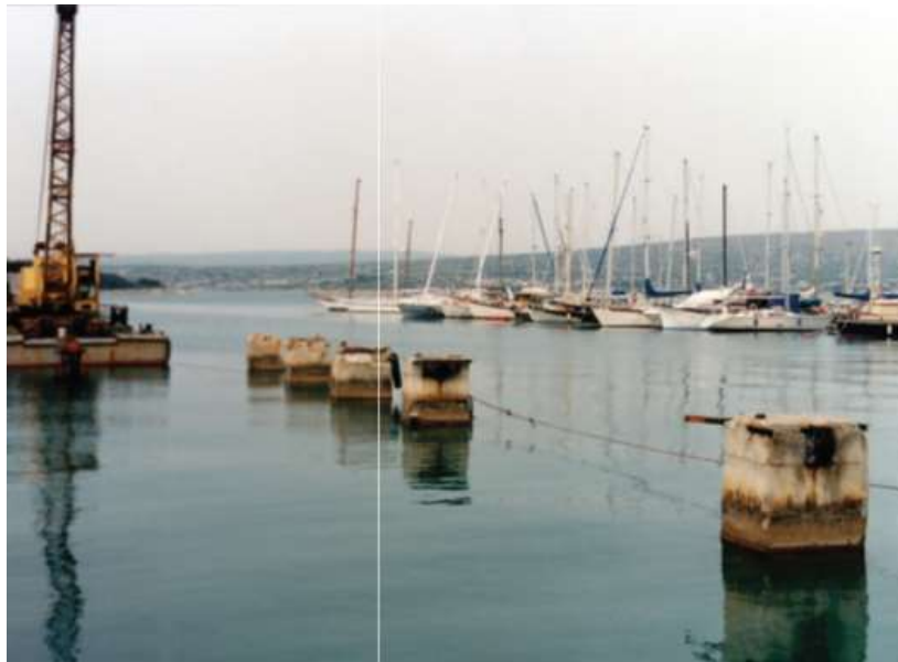
Slika 30: Prikazuje gat na garofunima [2]
