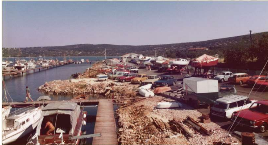
Slika 11: Prikazana je izvedba školjere [2]
