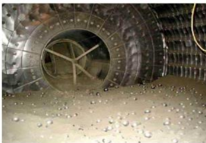
Slika 4. Mljevenje klinkera, unutrašnjost mlina s kuglama [1]
