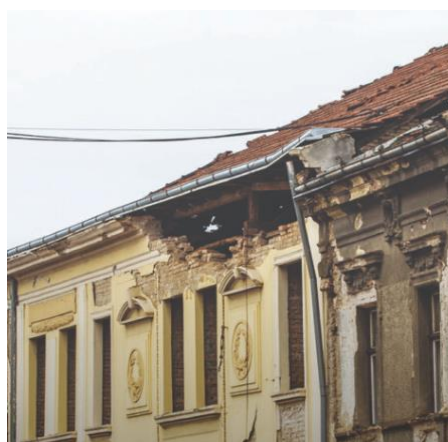
Slika 14. Formiranje horizontalnog luka nakon potresa u Petrinji 2020. godine [8]
