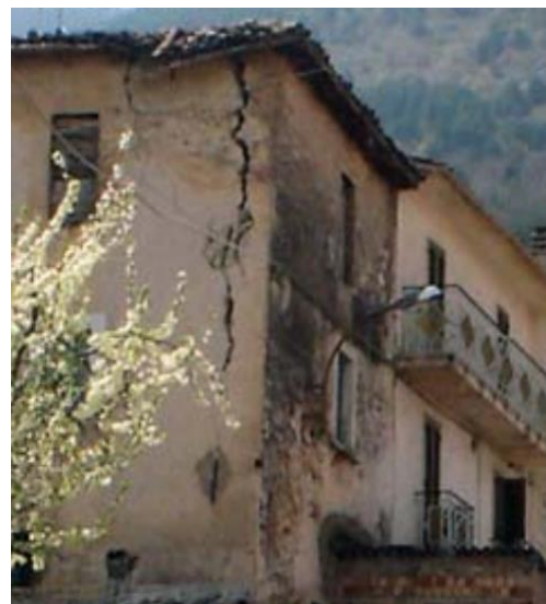
Slika 2. Prevrtanje zida pročelja: shema [2], primjeri [1]
