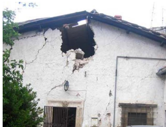
Slika 18. Prevrtanje lastavice zabata: shema [2], primjer [1]
