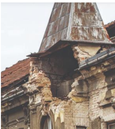
Slika 6. Slom ugla nakon potresa u Petrinji 2020.godine [8,10]
