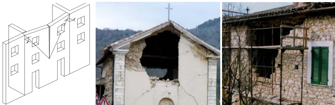
Slika 13. Formiranje horizontalnog luka: shema [2], primjeri [1]
