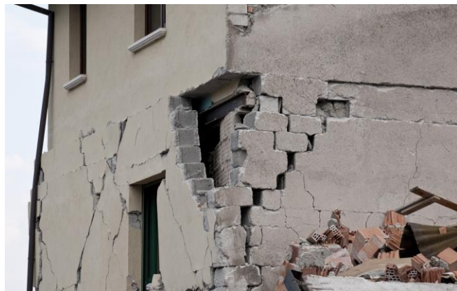
Slika 6. Slom ugla nakon potresa u Petrinji 2020.godine [8,10]
