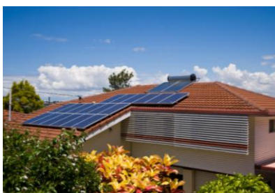
Slika 30. Solarni paneli na krovu kuće
