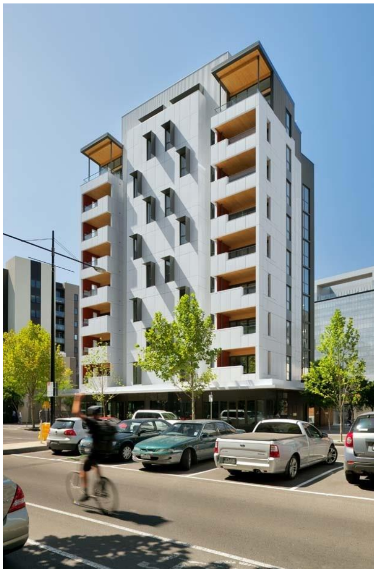
Slika 3: Stambena zgrada „Forte“ u Brisban, Australija [11]
