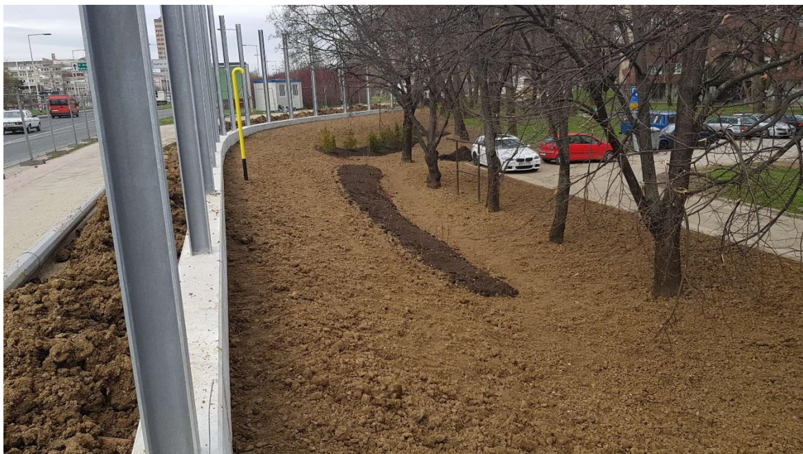
Slika 25: Primjer izgradnje zvučnih barijera, Vrbik [25]
