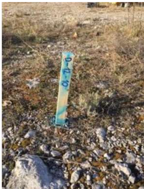
Slika 22: Geodetsko iskolčenje točaka na terenu [38]
