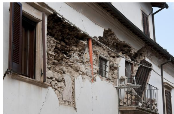
Slika 21. Lokalni slom zida: shema [2], primjer [10]
