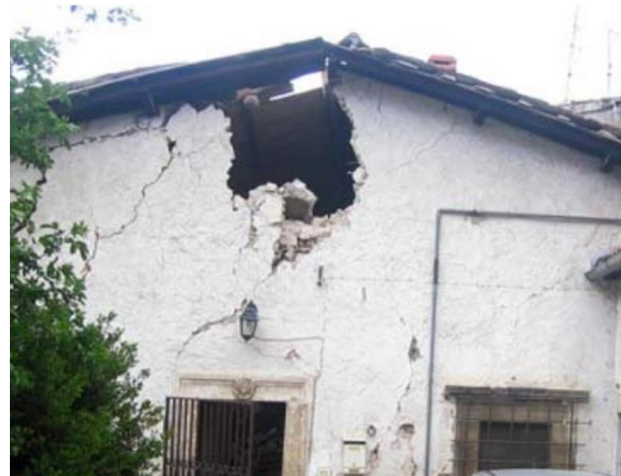
Slika 18. Prevrtanje lastavice zabata: shema [2], primjer [1]
