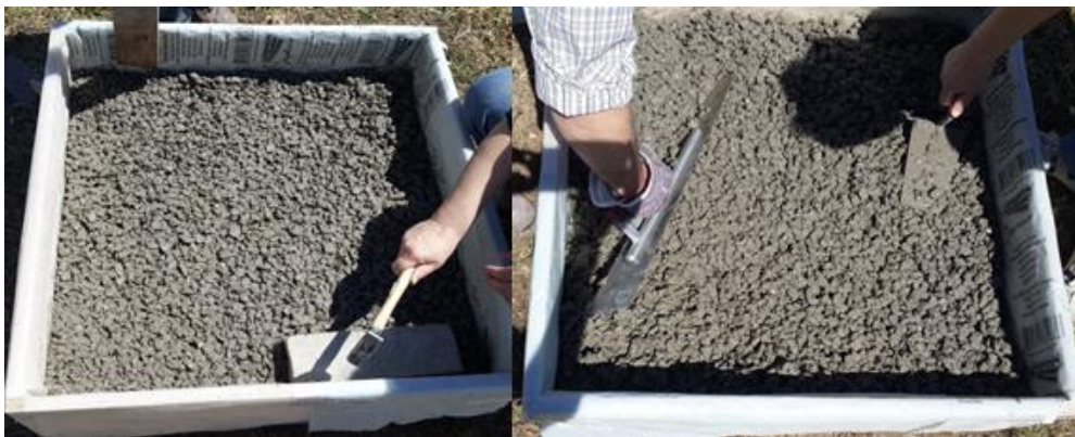
Slika 4.16 Proces ugradnje porozno – betonskih ploča [26]
