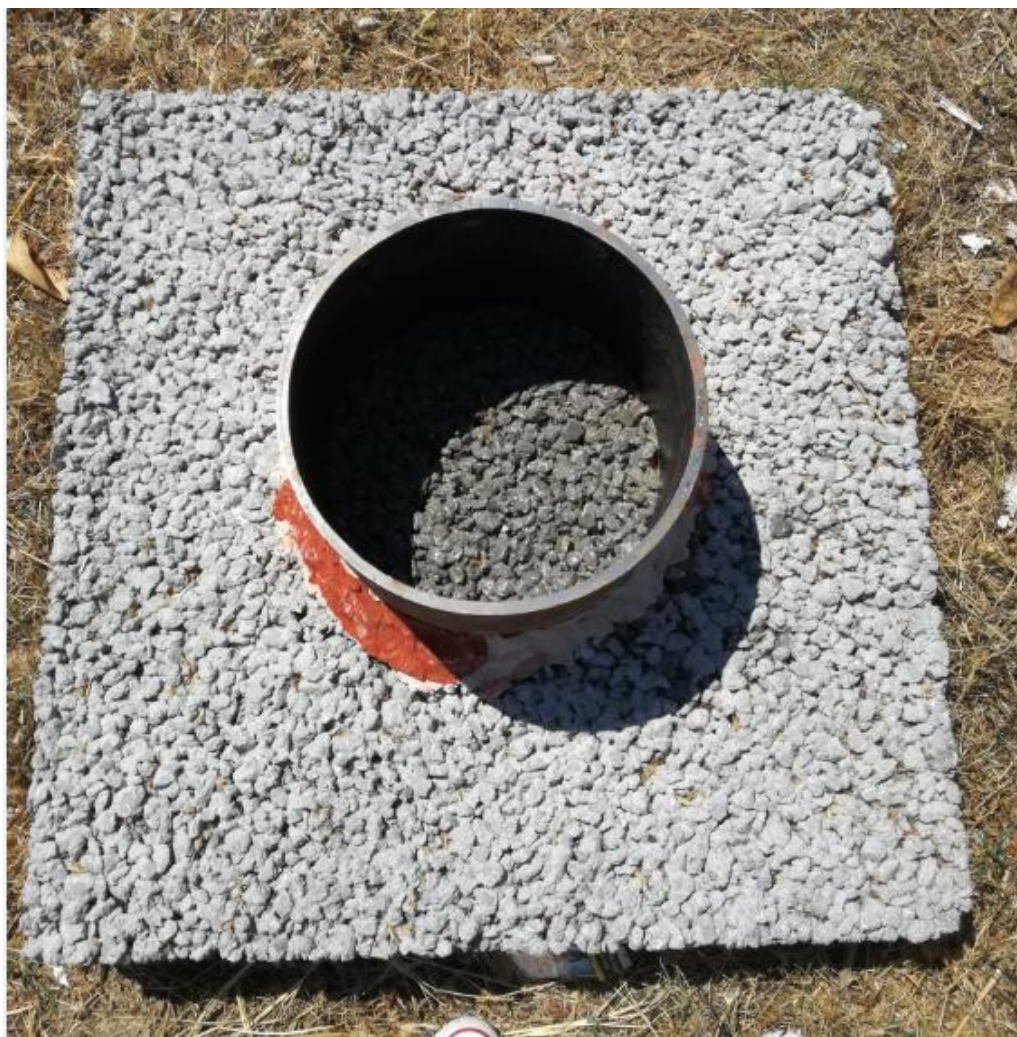
Slika 4.18 Čelični prsten postavljen na porozno – betonsku ploču
