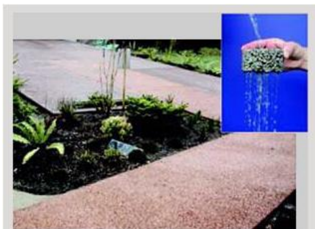
Slika 1.5 Porozni beton može smanjiti površinsko otjecanje i puniti zalihe podzemne vode [14]
