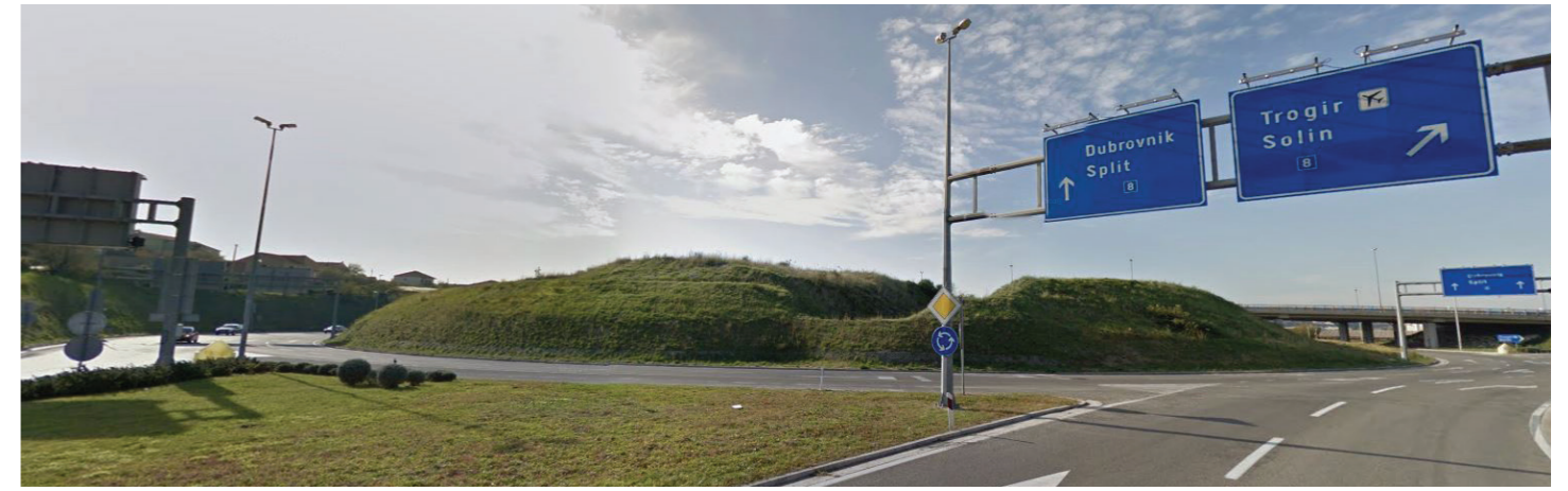
Pogled na lokaciju_priklučivanje ceste D1 na D8
